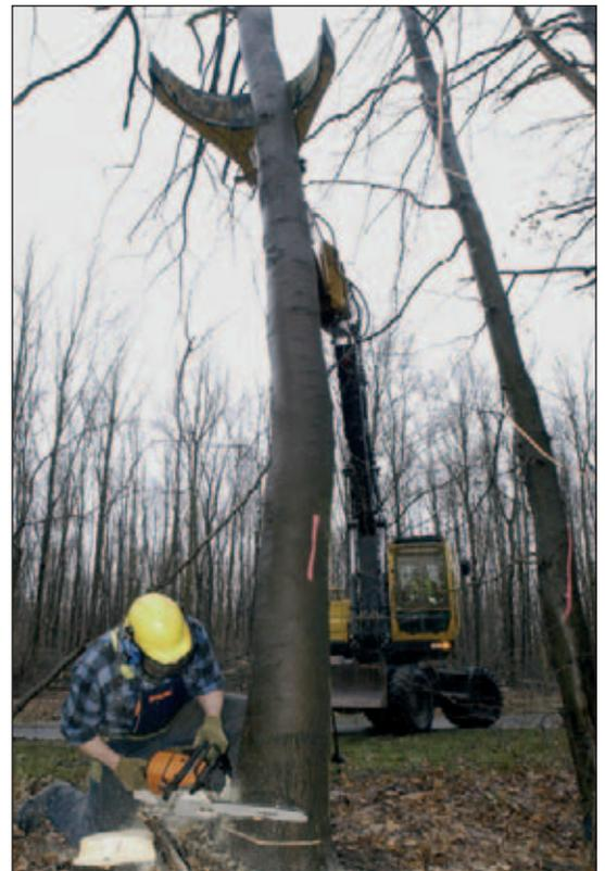
**Die Fällung des Baumes wird durch die Anlage eines Fallkerbs vorbereitet. Der Fällschnitt wird soweit reduziert, dass eine starke Bruchleiste stehen bleibt. Erst wenn der Motorsägenführer den Gefahrenbereich verlassen und dies über Helmfunk dem Baggerführer mitgeteilt hat, wird der Baum zu Fall gebracht.**
